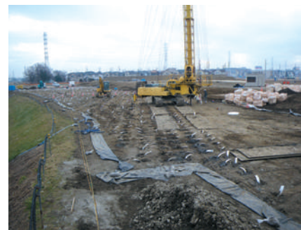
鉛直ドレーン打設 従来のプラスチックドレーンと同様の機械で打設します。
