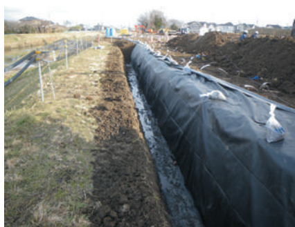
シート端部処理 シート端部は改良エリアの外側に埋込み漏気を防止します。
