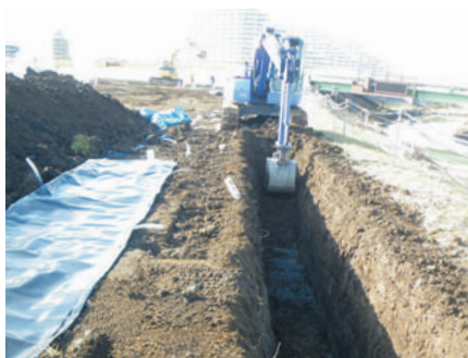
シート端部掘削 粘性土地盤にシート端部が達するように掘削します。
