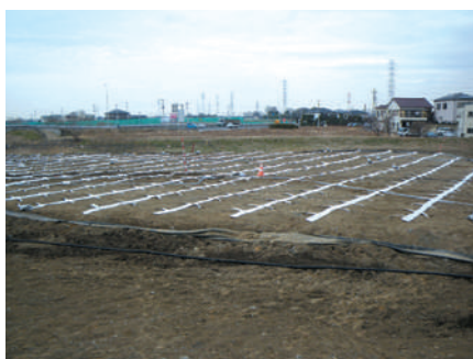
水平ドレーン・配管 排水システムである水平ドレーン、集水管を布設します。
